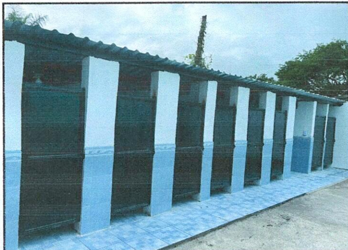
Foto 1: REPARACION DE BAÑOS
